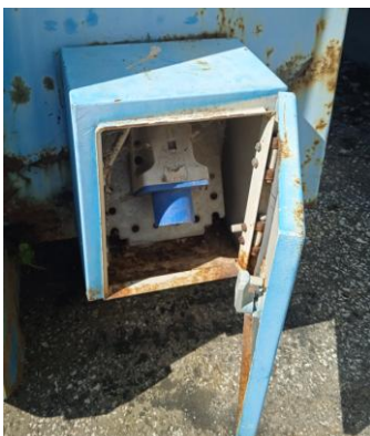
Foto 1. Olemasoleva elektrisoojenduse pistik
