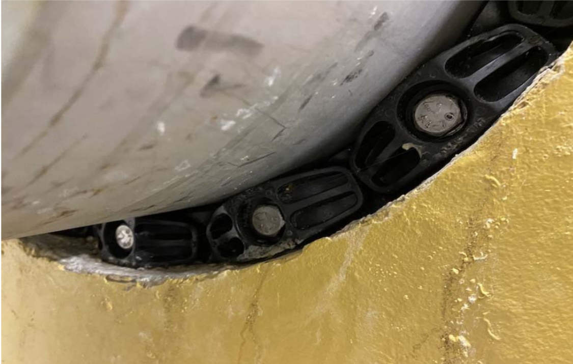
Foto 20. Toru läbiviigu ava on seinä puuritud ning toru ja ava vaheline tühimik on täidetud kummitihendi ja plastikust pingutitega.
