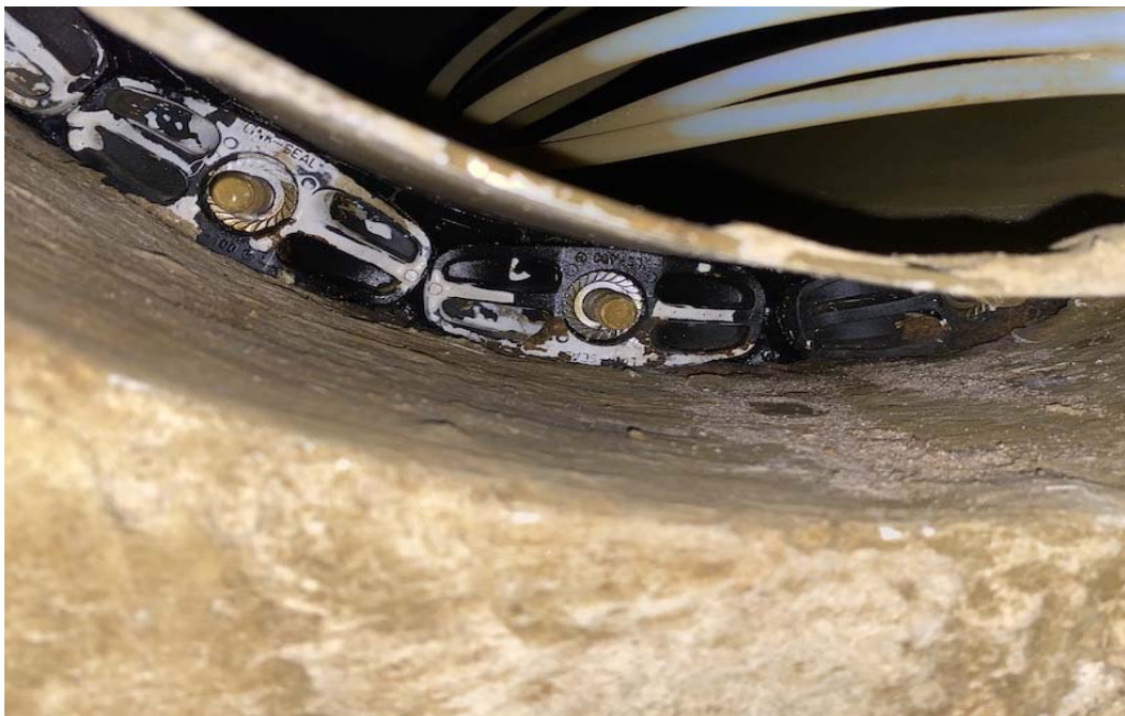
Foto 21. Toru läbiviigu ava on seinä puuritud ning toru ja ava vaheline tühimik on täidetud kummitihendi ja plastikust pingutitega.
