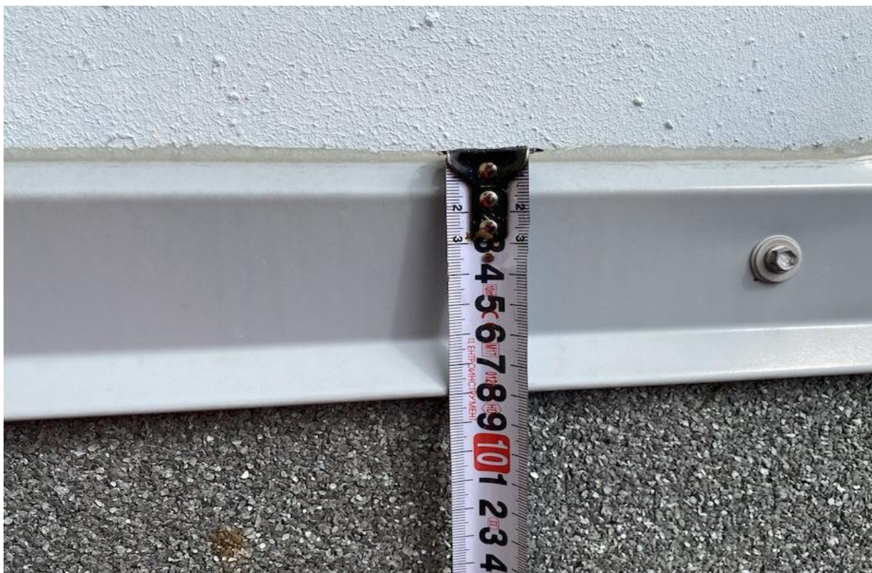
Foto 37. Katusekate on keeratud projektikohaselt külgsentele ja lõpetatud katteplekiga.
