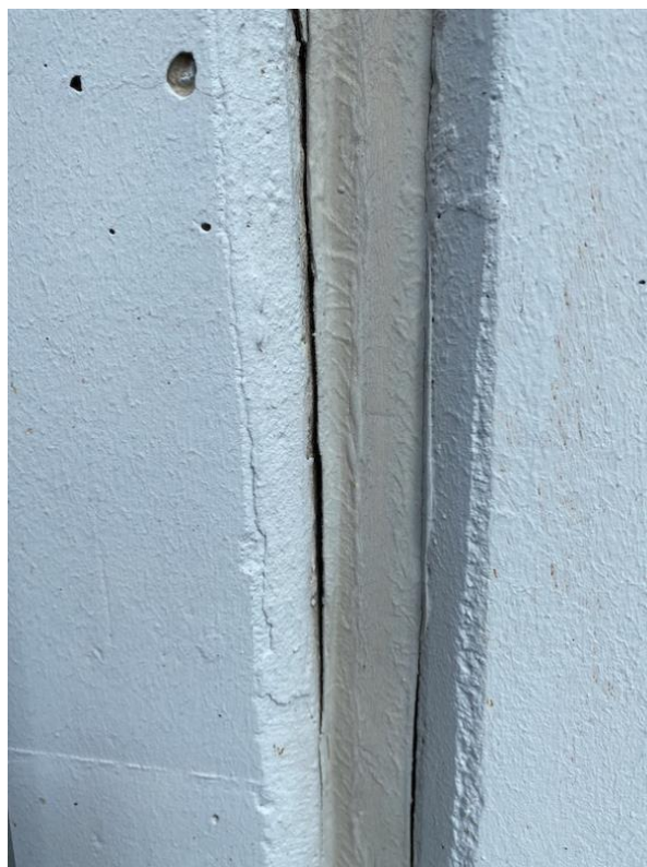
Fotod 34-35. Trepikoja välisseina monteeritavate r/b paneelide vuugitäide on praguline, osaliselt servadest lahti, muutunud kohati kõvaks ja olukorda on proovitud korrastada kohtparandustega.
