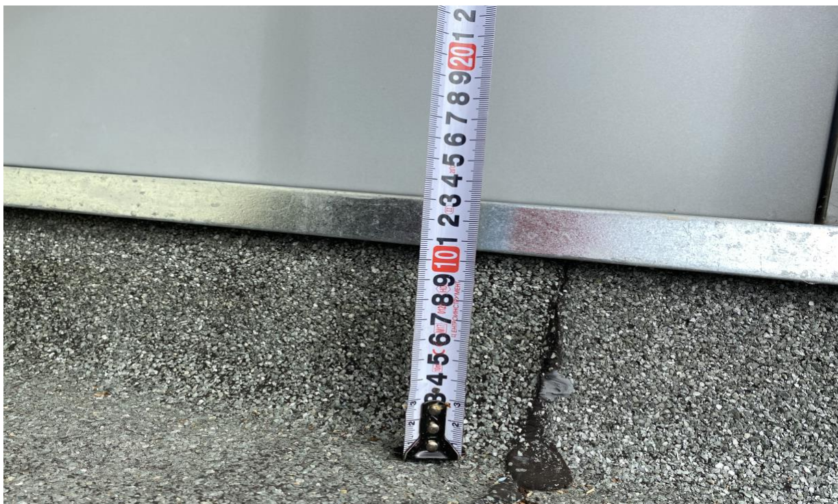
Foto 28. Katuse uksepaku kõrgus on ca 130mm.
