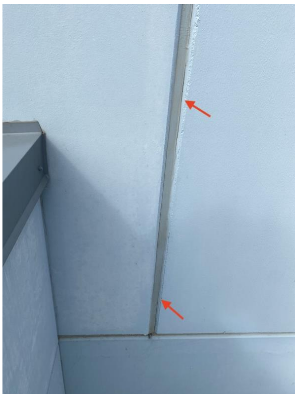
Fotod 34-35. Trepikoja välisseina monteeritavate r/b paneelide vuugitäide on praguline, osaliselt servadest lahti, muutunud kohati kõvaks ja olukorda on proovitud korrastada kohtparandustega.
