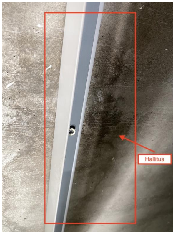
Fotod 13-14. Koridori lakke tekkinud niiskuskahjustused asuvad trepikojast katuselae pääsu ukse all vahelae konstruktsioonil.
