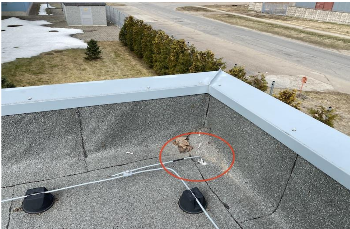
Foto 46. Katuse piksemaanduse läbiviik katusekattest ei ole veetihe.
