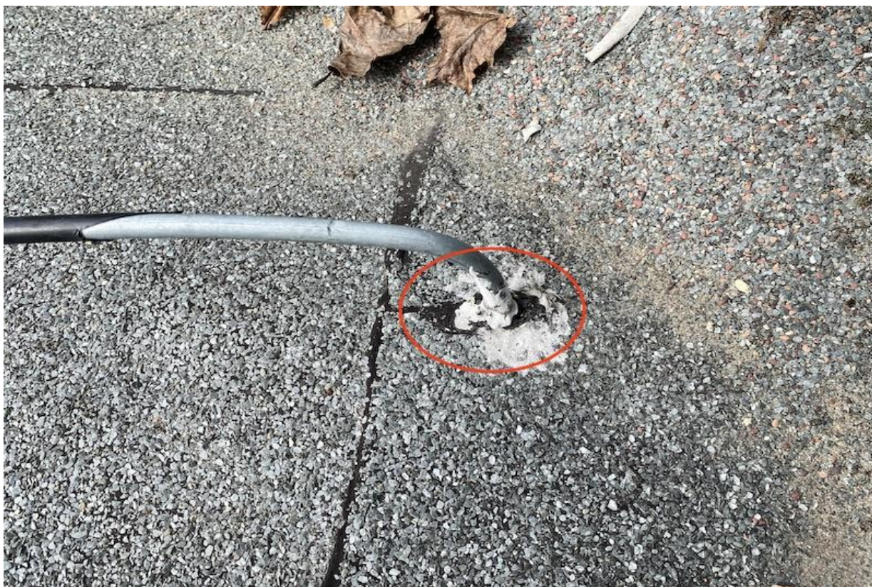
Foto 47. Katuse piksemaanduse läbiviik katusekattest ei ole veetihe.
