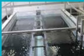
После фильтрации вода поступает на дезинфекцию ультрафиолетом, который уничтожает все микробы и бактерии.
