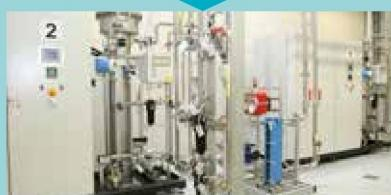
Потом ещё раз воду фильтруют с помощью фильтров, заполненных гранулированным активированным углём, который улучшает вкус и цвет воды.
